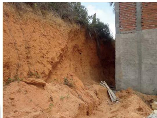
Cortes verticais inadequados nos taludes para a construção de empreendimento - Aracaju.
