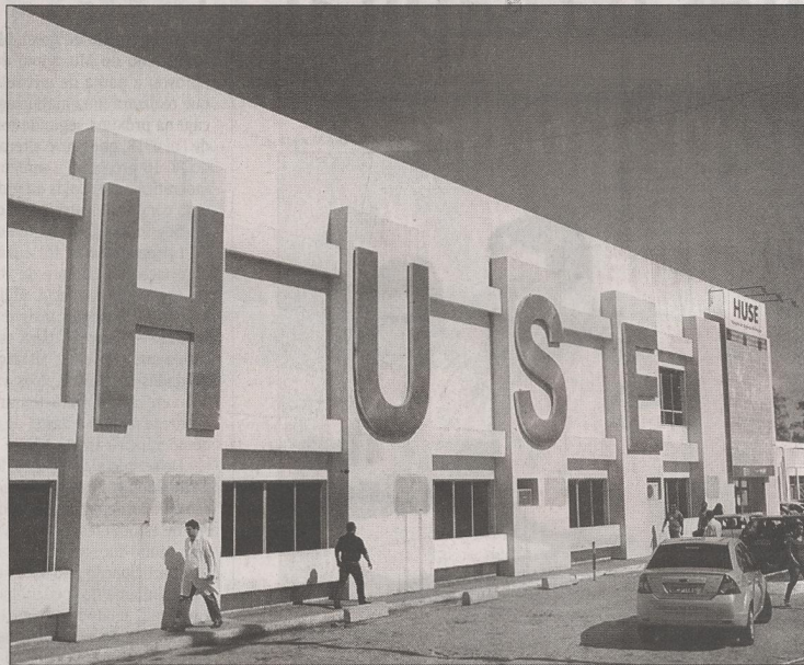
SE OS HOSPITAIS do interior do Estado estivessem atendendo a contento, Huse não estaria sobrecarregado
