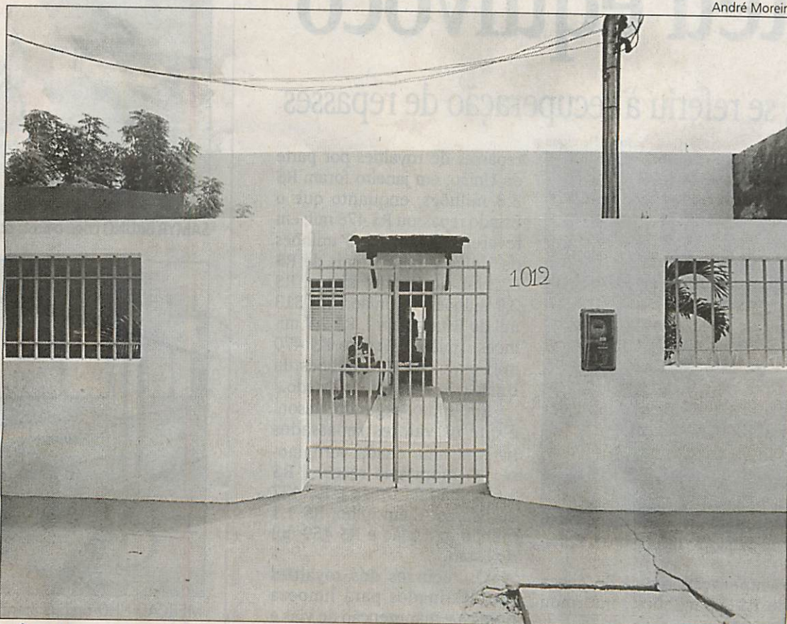
PRÉDIO foi vistoriado em abril pela Vigilância Sanitária que registrou sujeira mofo e ferrugem em móveis e paredes
