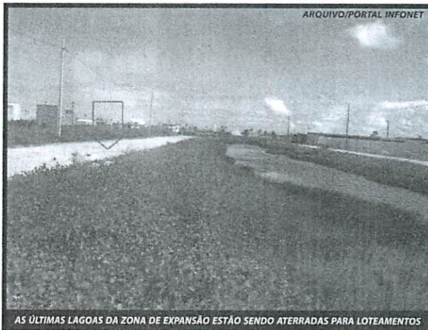
AS ÚLTIMAS LAGOAS DA ZONA DE EXPANSÃO ESTÃO SENDO ATERRADAS PARA LOTEAMENTOS
