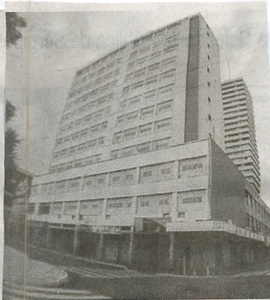
Primeira vistoria acontecerá nas instalações do antigo Hotel Palace
