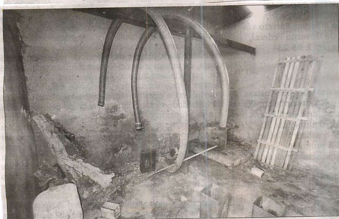
MORADORES fizeram um abaixo-assinado relatando a falta de condições do matadouro
