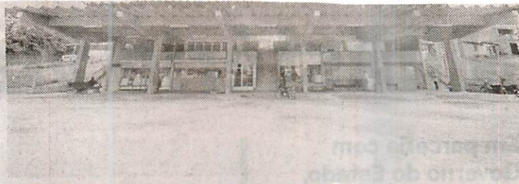
Vista frontal da Estação Rodoviária de Estância
