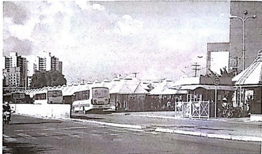
■ Críticas dos usuários do transporte coletivo sobre a estrutura do terminal são inúmeras
