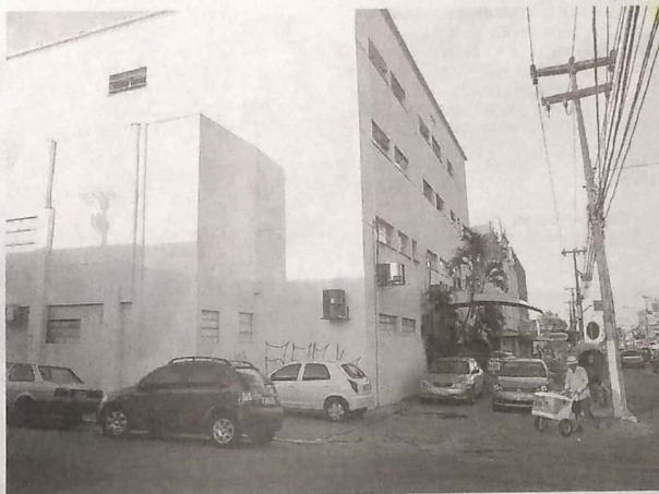
■ Direção do Hospital de Cirurgia ressaltou que a obra do setor de cardiologia já foi concluída
